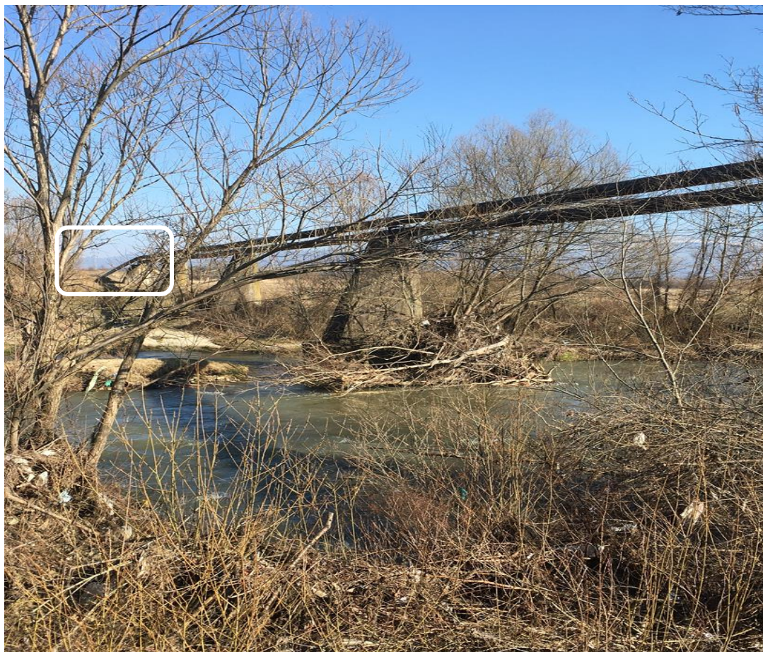
Zona execuție lucrări de reizolare conductă – circa 73 m de malul drept râul Timiș
