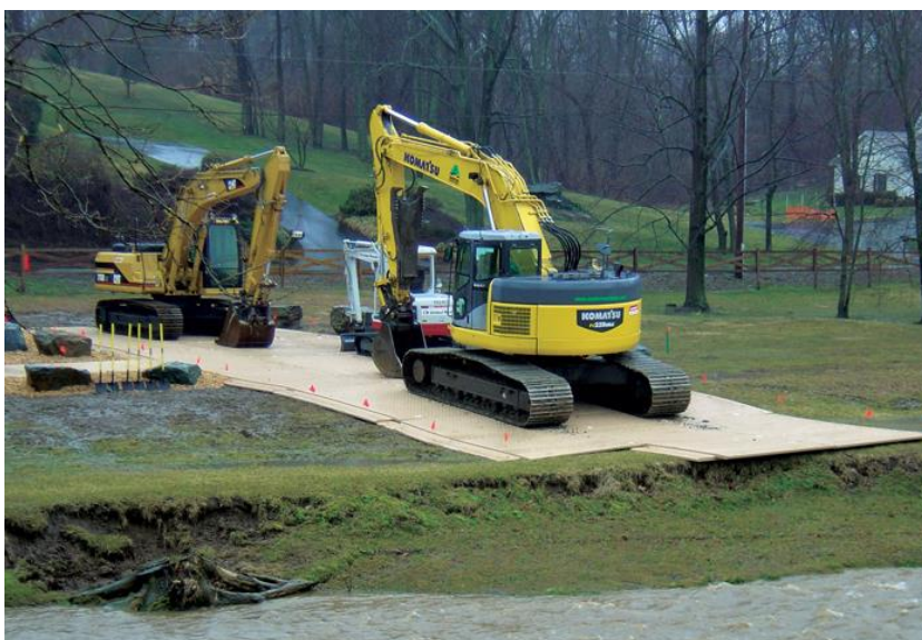
Foto: Exemplu utilizare plăci modulare HDPE pentru utilaje grele
