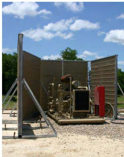
Figura nr. 5-5 Exemplu de panouri fonoabsorbante mobile recomandate pentru lucrările de construcție ale căii ferate București - Giurgiu
