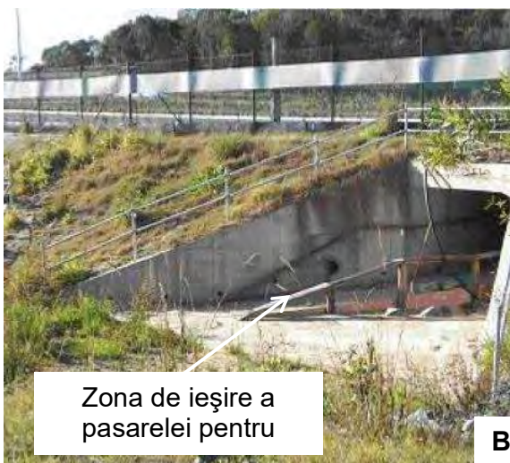
Figura nr. 5-7 A. Subtraversare adaptată pentru particularitățile de deplasare a mai multor specii; B. Zona de ieșire a unei subtraversări adaptată pentru mai multe specii; C: Exemplu de utilizare al unei pasarele de către un individ al speciei Lutra lutra
