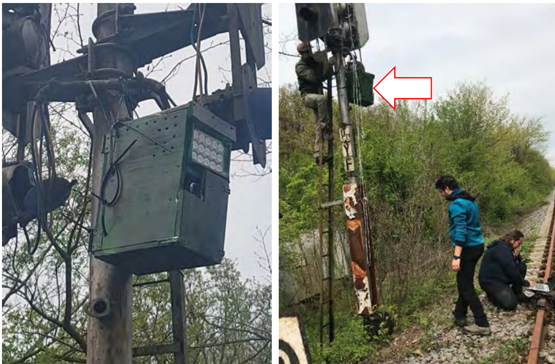
Figura nr. 6-6 Camera video cu înregistrare continuă și montarea acesteia
