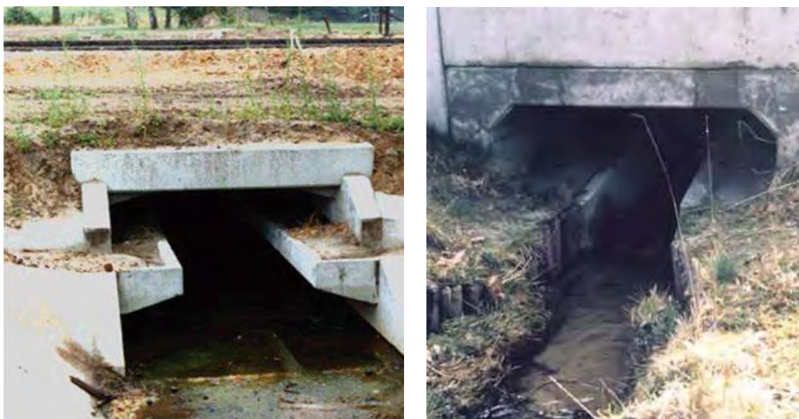
Figura nr. 5-6 Exemple ale unor subtraversări pentru specii de faună de dimensiuni mici, similare celor propuse ca măsură pentru menținerea conectivității
