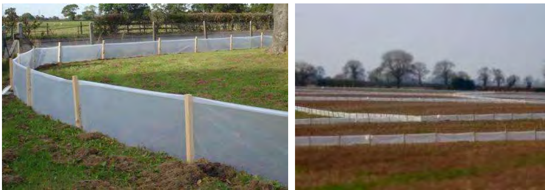
Figura nr. 5-3 Exemple ale unor garduri temporare pentru amfibieni
