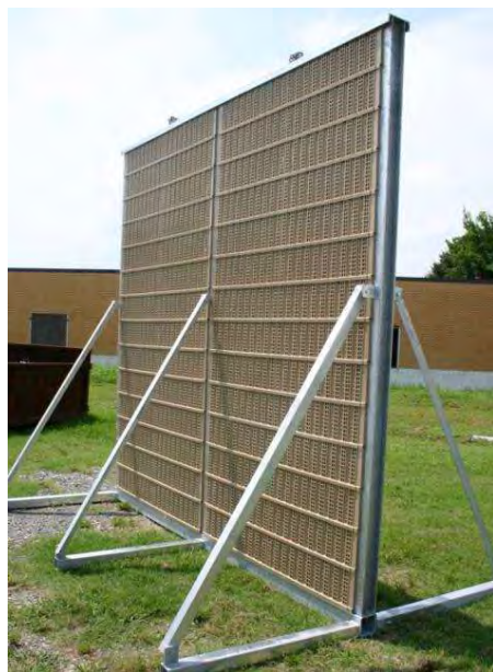
Figura nr. 5-5 Exemplu de panouri fonoabsorbante mobile recomandate pentru lucrările de construcție ale căii ferate București - Giurgiu
