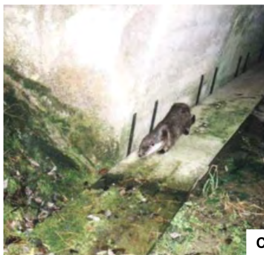
Figura nr. 5-7 A. Subtraversare adaptată pentru particularitățile de deplasare a mai multor specii; B. Zona de ieșire a unei subtraversări adaptată pentru mai multe specii; C: Exemplu de utilizare al unei pasarele de către un individ al speciei Lutra lutra
