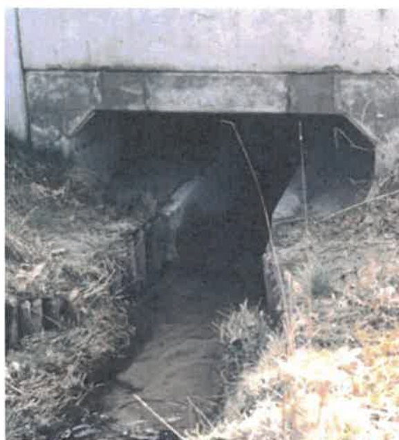
Figura nr. 5-6 Exemple ale unor subtraversări pentru specii de faună de dimensiuni mici, similare celor propuse ca măsură pentru menținerea conectivității
