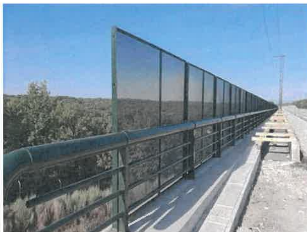
Figura nr. 5-4 Exemplu de panouri anticolidiune (atenție, panourile din exemplu nu au înălțimea de 3m)
