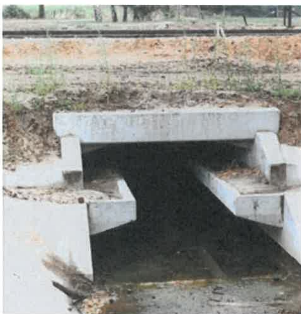
Figura nr. 5-6 Exemple ale unor subtraversări pentru specii de faună de dimensiuni mici, similare celor propuse ca măsură pentru menținerea conectivității
