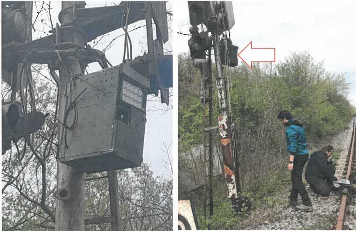
Figura nr. 6-6 Camera video cu înregistrare continuă și montarea acesteia
