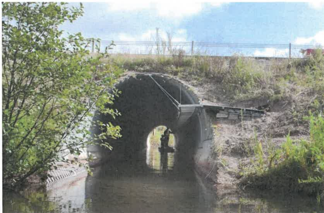
Figura nr. 5-8 Exemplu al unui podeț dotat cu pasarela pentru deplasarea faunei (sursa: https://www.adirondackalmanack.com/2017/10/critter-shelf-wildlife-pilot-project-underway.html )
