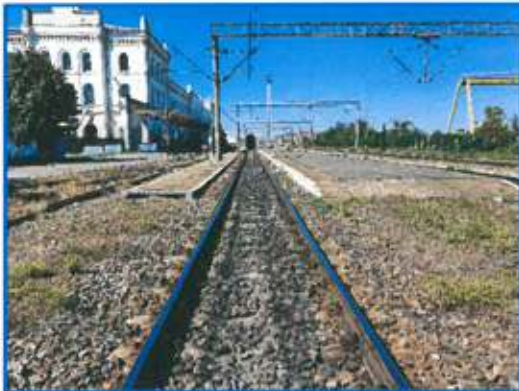
Linia c.f. în zona gării Suceava Nord (Ițcani)
