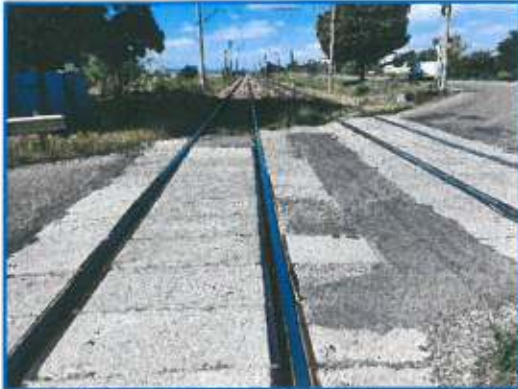
Linia c.f. în zona trecerii la nivel km 433+750
