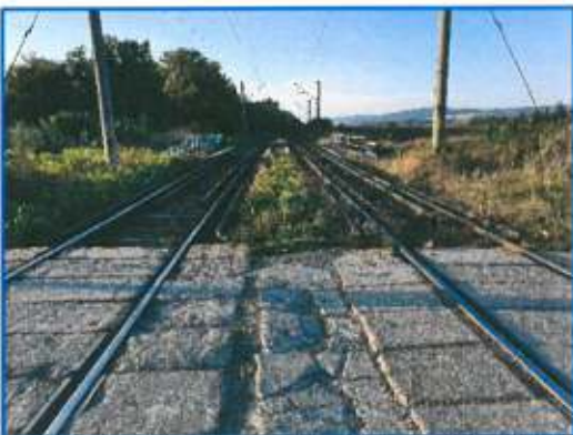
Linia c.f. în zona trecerii la nivel km 398+995
