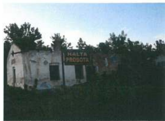
Clădire de călători din Punctul de oprire Probota
