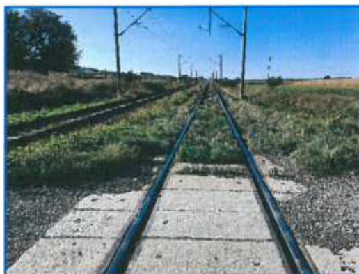
Linia c.f. în zona trecerii la nivel km 411+975
