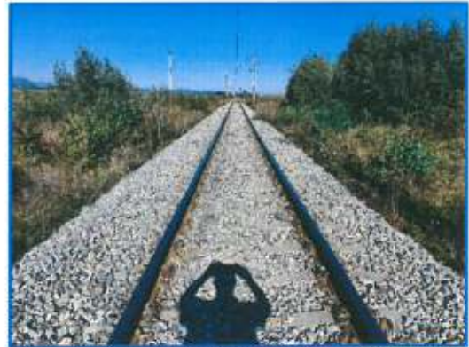
Linia c.f. în zona trecerii la nivel km 453+296
