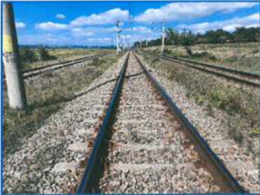
Linia c.f. în zona km 437+600
