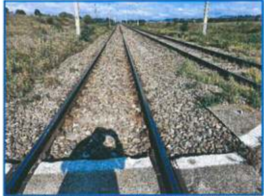
Linia c.f. în zona trecerii la nivel km 441+450
