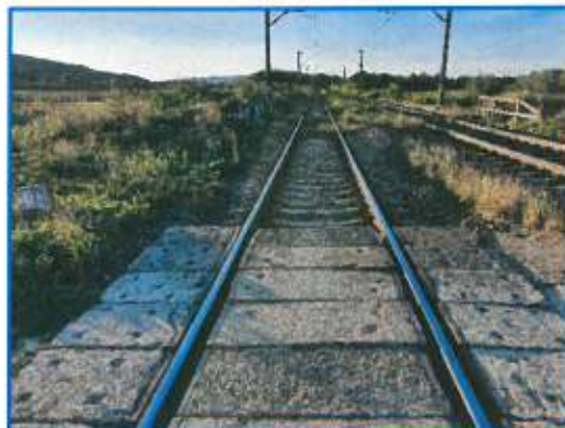
Linia c.f. în zona trecerii la nivel km 404+588
