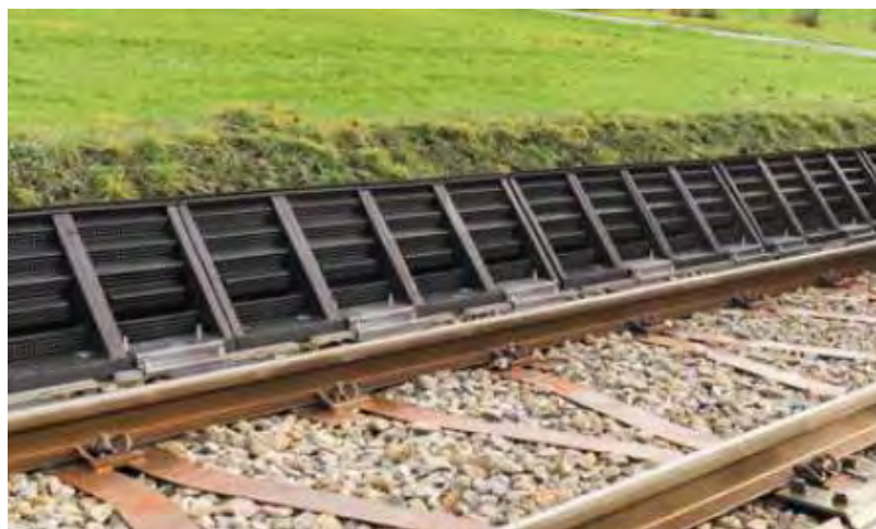
Figura nr. 2-3 Exemplu de sistem de protecție împotriva zgomotului montat pe traversă
