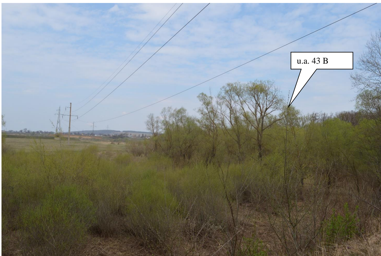
Figure 40. Aspectul zonelor propuse pentru scoaterea din fond forestier UP IX, u.a. 43 B
