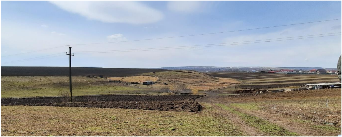
Figura nr. 3-6 Aspectul din teren a construcțiilor din zona km 0+500-0+550
