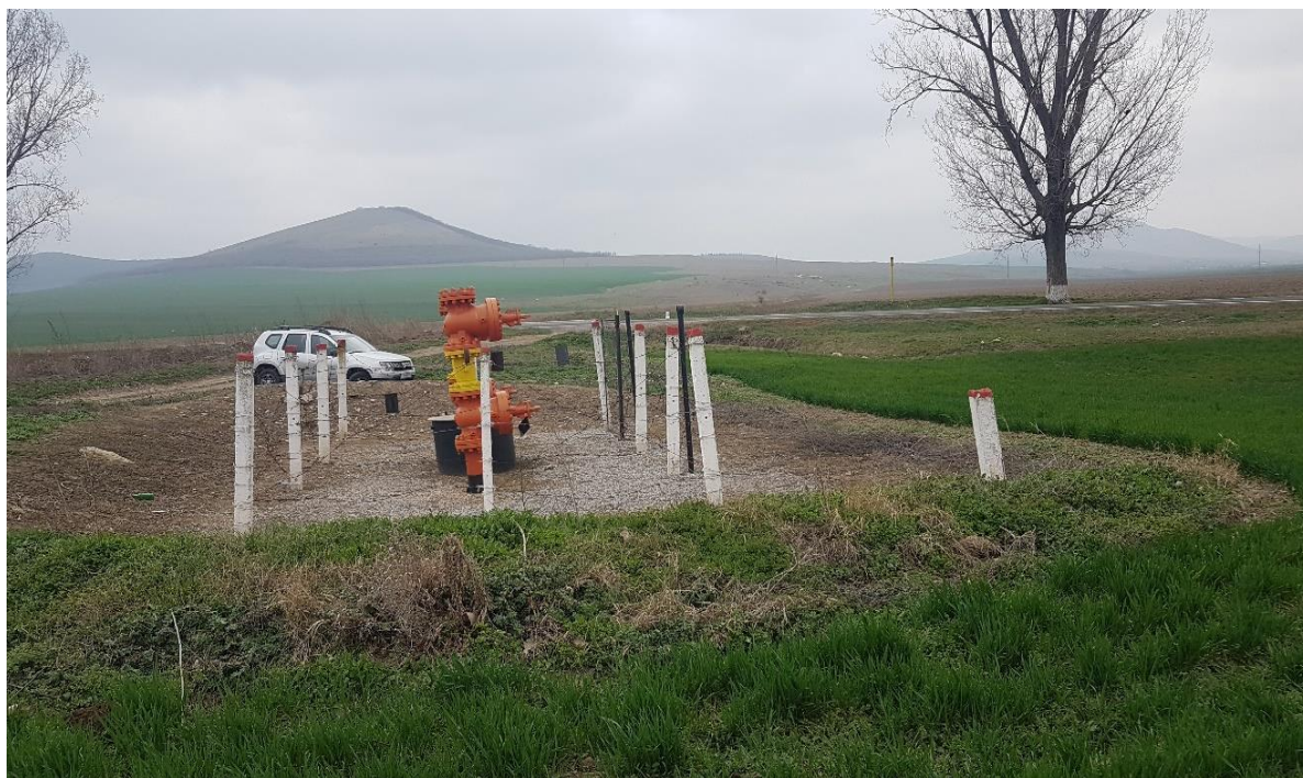
Fig. 14. Amplasament pct. Intervenție robinet P2 și TS-DN22A (UAT Nalbant)
