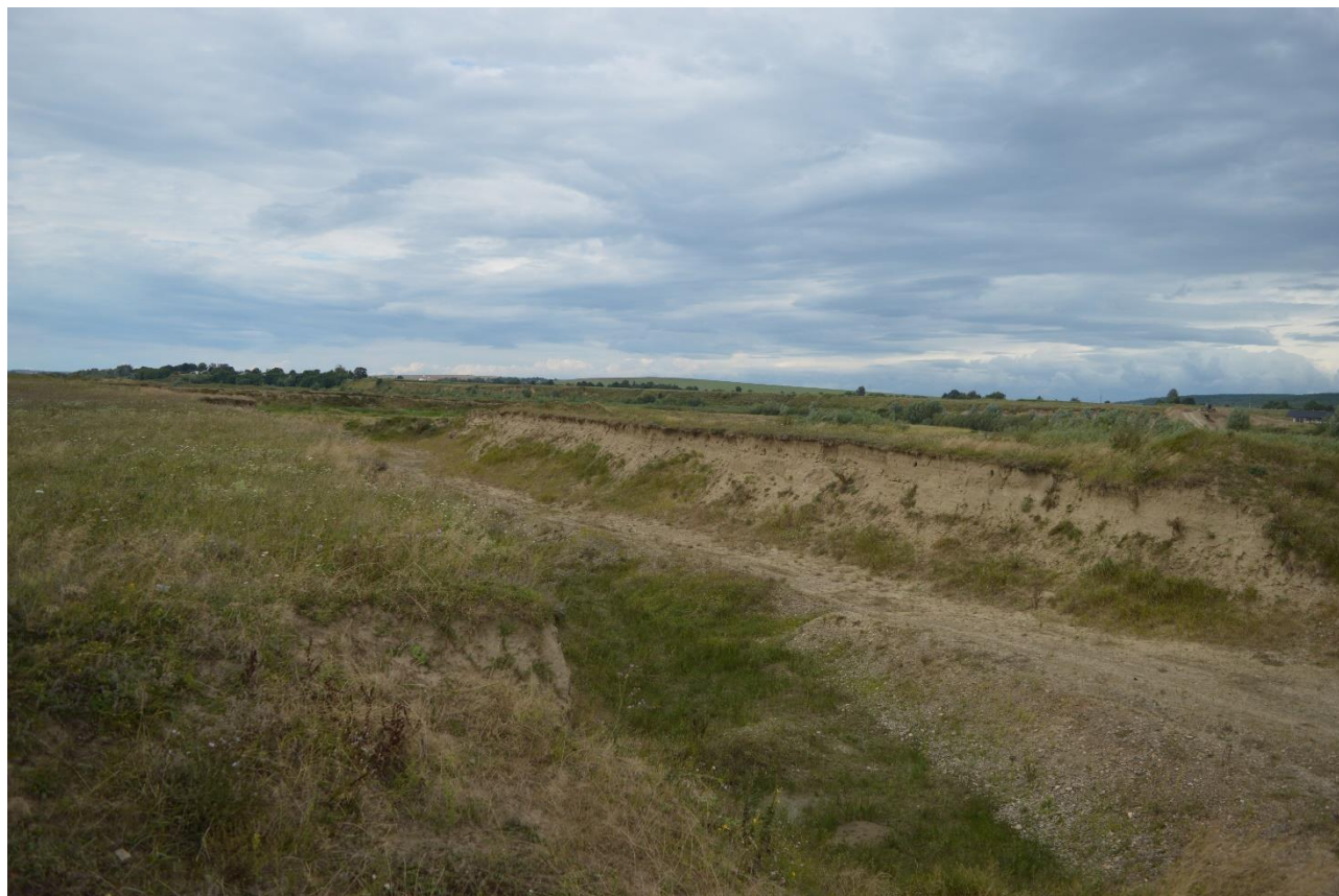
Figure 22. Declivități la nivelul cuvetei acumulării rezultate din exploatarea de balast folosit la umpluturi în corpul digurilor
