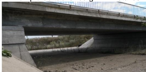
Figura 4 - Exemplu grinzi metalice înglobate în beton
