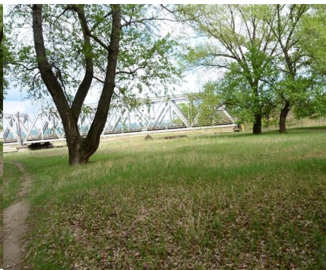
Pod actual de cale ferată peste râul Troțuș
