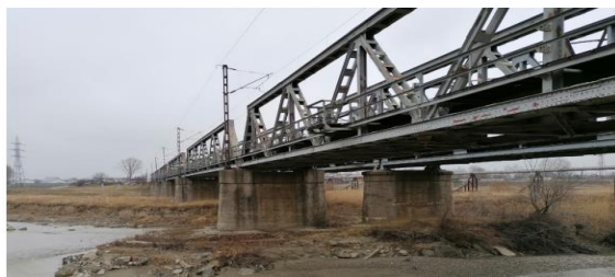
Figura 16 - Exemplu grinzi cu inimă plină cale jos
