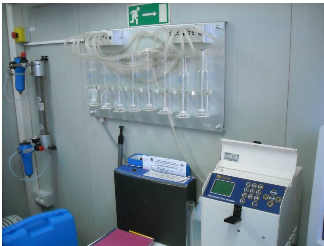
Figura nr. I.1.1.1.12. – Sistem de prelevare formaldehidă – AB2- Sebeș
