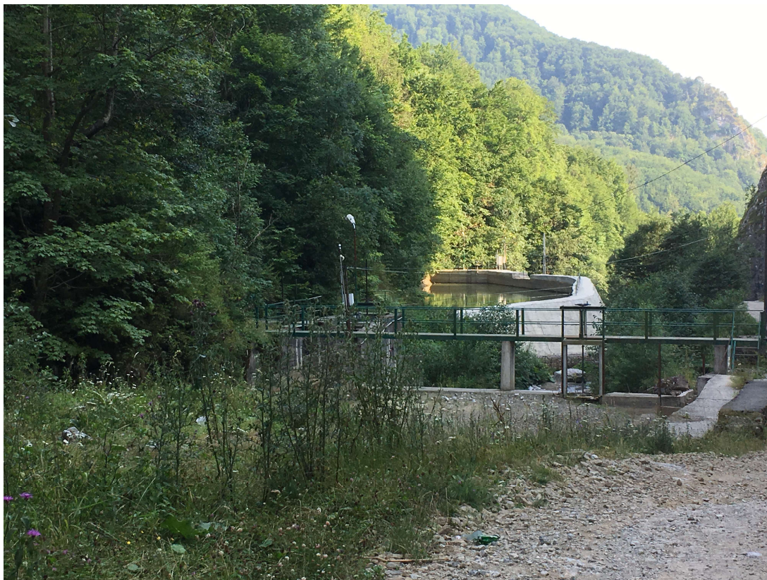
Captarea MHC Cheile Fenesului
