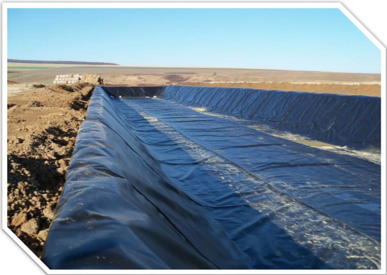
Fig..Laguna tehnologică Gârbova după realizarea impermeabilizării cu geo membrană
