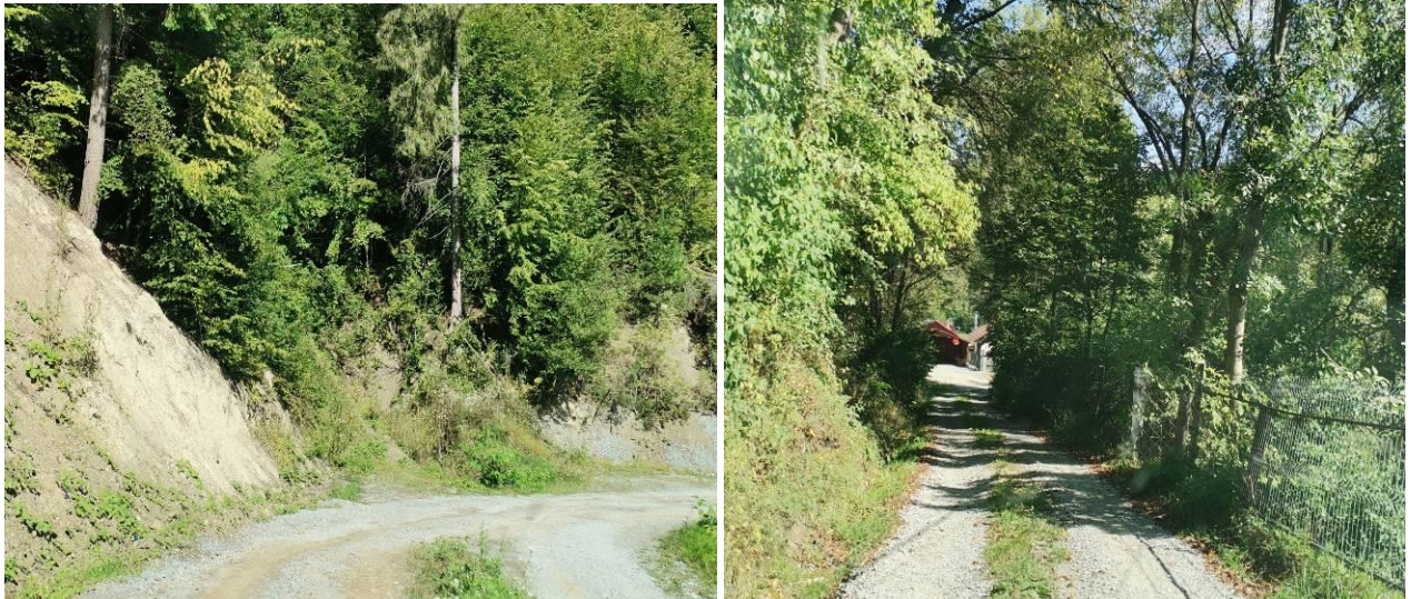
Fig. 7,8 Situatia existenta a drumului local Coasta Hentii
