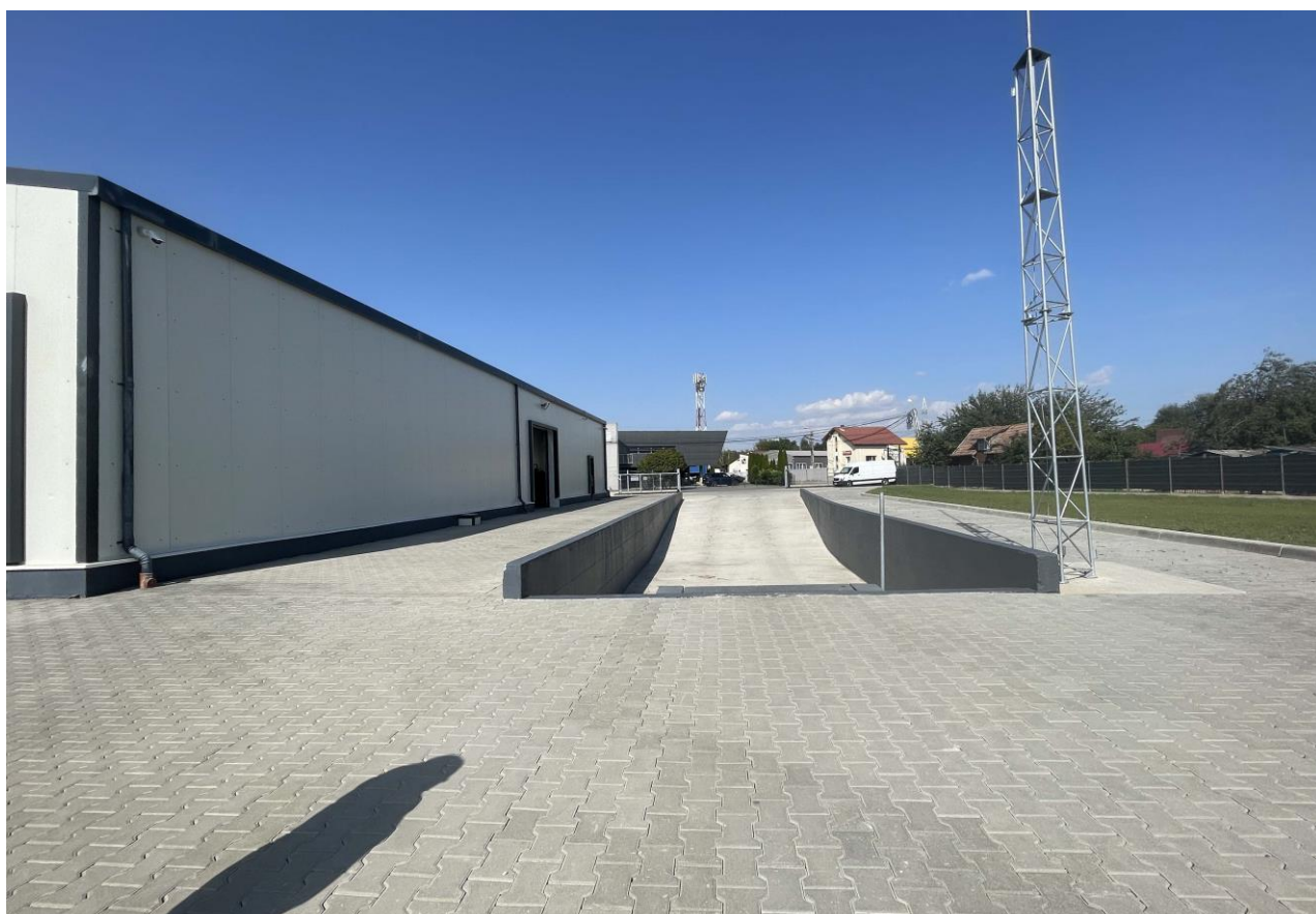
Hala existentă pe amplasament
