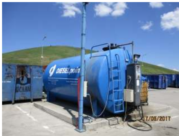
Poza 12 Statie alimentare combustibili
