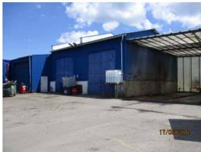
Poza 7 Hala spalare
