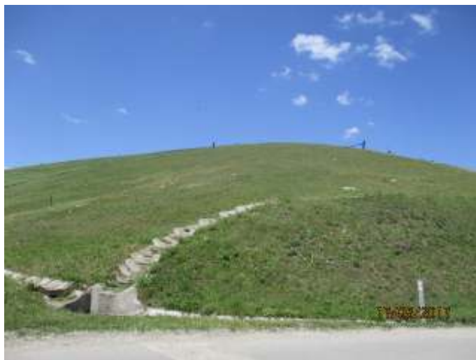
Poza 3 Sector depozit inchis
