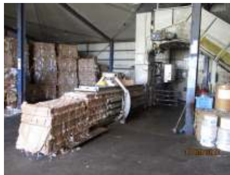
Poza 9 Presa balotat
