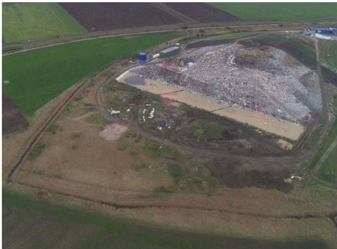
Poza 1 Imagine de ansamblu sectoare depozitare deseuri FCC Arad
