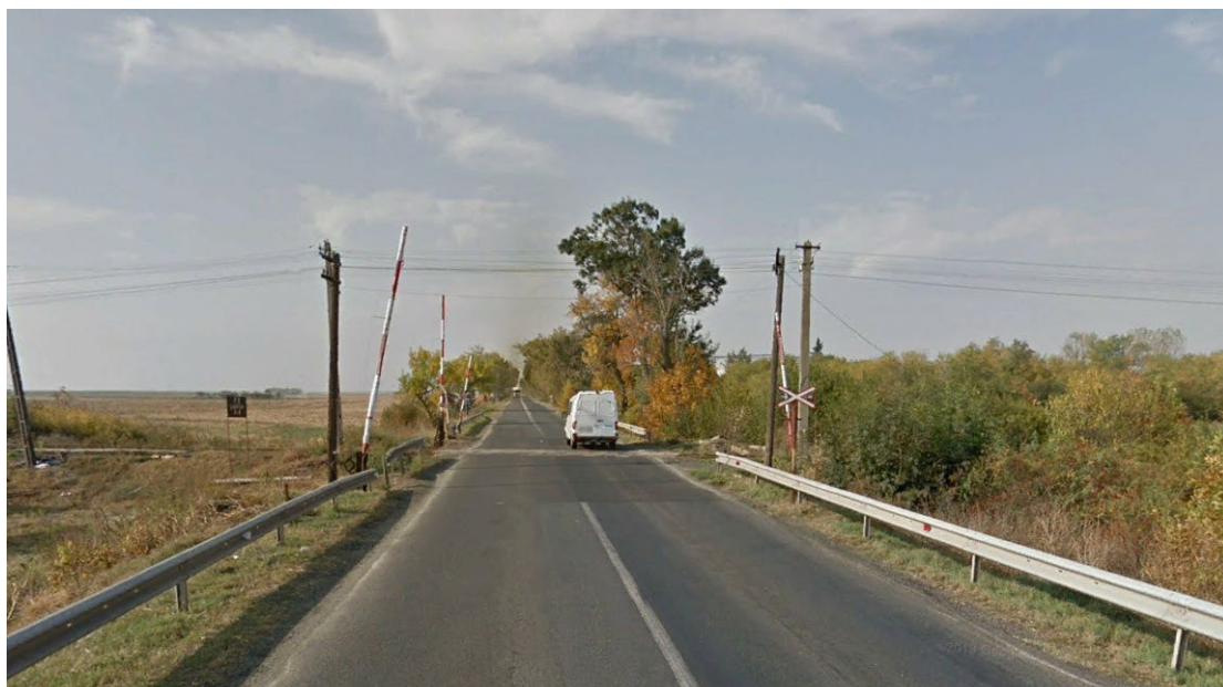
Figura nr. 82 - Trecere la nivel cu bariere mecanice, intersecție DN 7 / CF km 9+572
