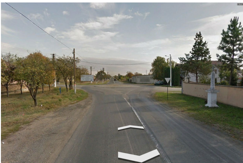
Figura nr. 69 - Intersecție insuficient amenajată din punct de vedere al semnalizării rutiere, intersecție DJ 682 / DJ 709E
