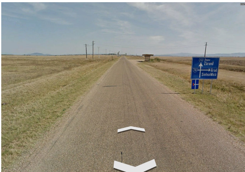
Figura nr. 70 - Intersecție insuficient amenajată din punct de vedere al semnalizării rutiere, intersecție DJ 791 / DJ 792
