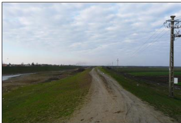
Digul de protecție al Crisului Alb
