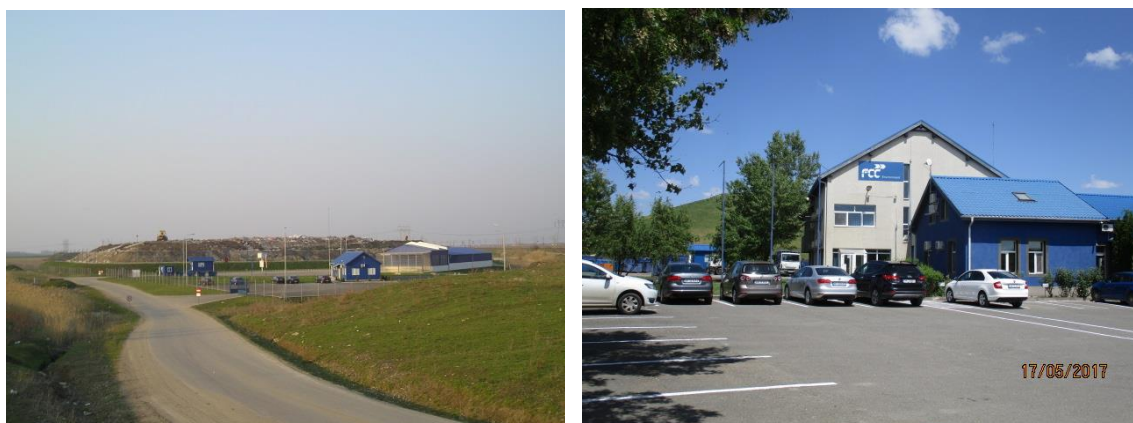
Imagine 1 Drumul de acces catre depozitul de deșeurii nepericuloase administrat de S.C. FCC ENVIRONMENT ROMANIA S.R.L. și clădirea administrativă a acestuia
