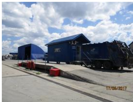
Imagine 2 Cabina cântar și platforma electronică de cântărire ce deservesc depozitul de deșuri nepericuloase administrat de S.C. FCC ENVIRONMENT ROMANIA S.R.L.
