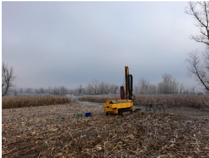
Foto: Locația forajului geotehnic F5 – Barța Est 2, teren agricol
