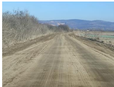
Drumul de acces spre amplasamentul proiectului
