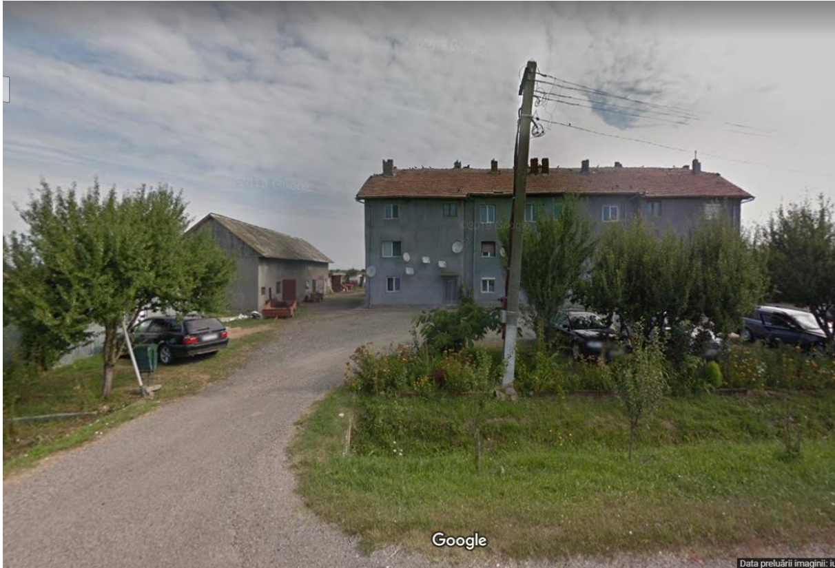
Complex agricol pe partea stângă a DN7B spre Turnu (sursa: Google maps)
