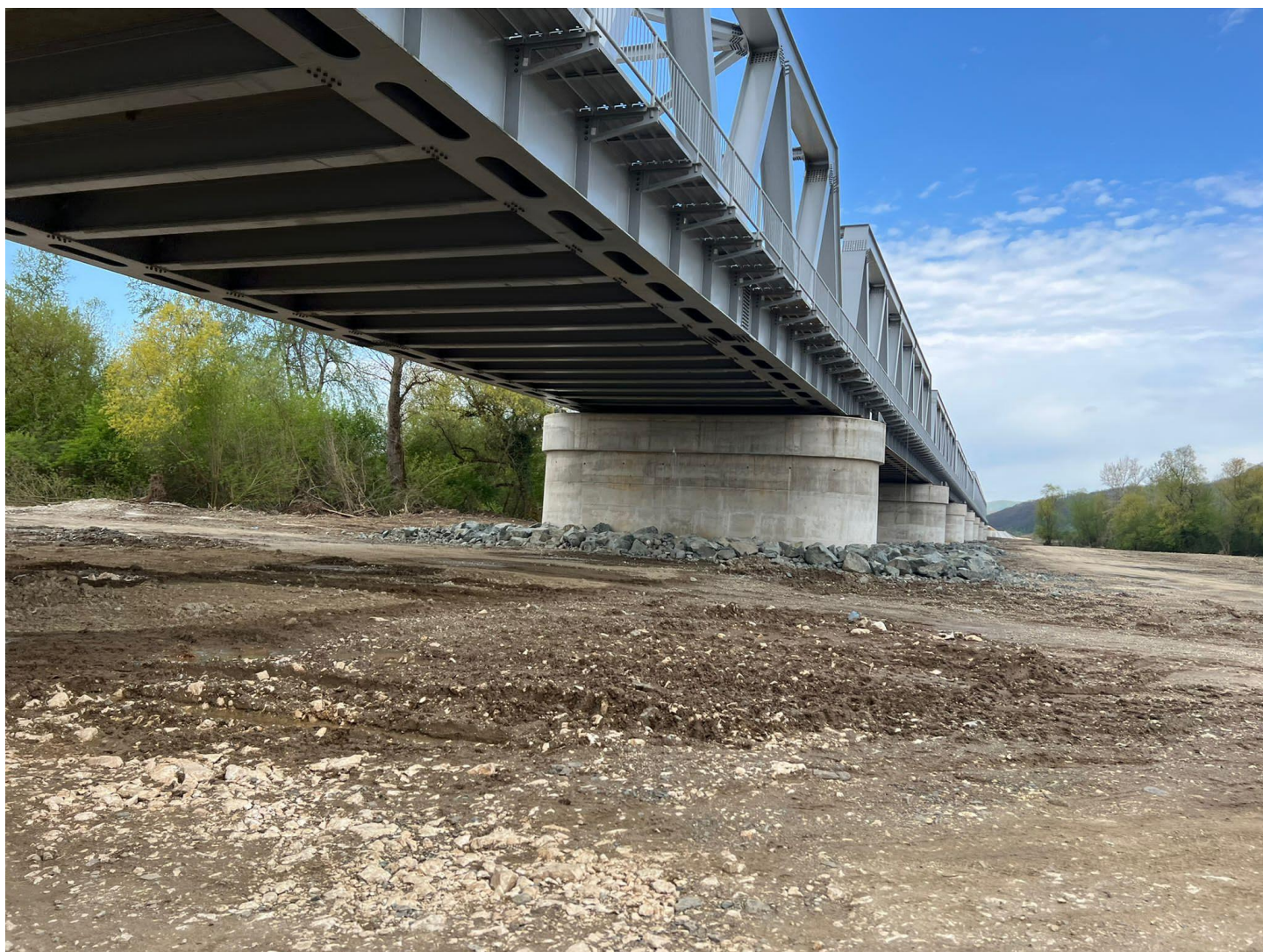
Foto nr. 15 Înălțimea și lungimea pilelor și interpilelor podului de cale ferată în zona amplasamentului proiectului
