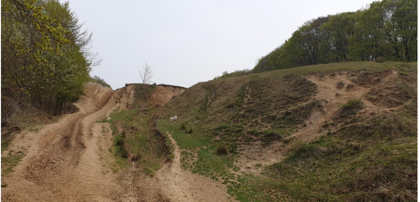
Eroziuni dezvoltate pe drumuri de acces (Oratia)
