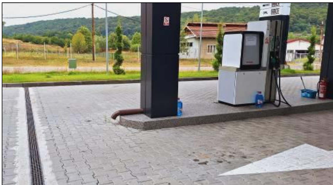
Figura 4 – Stia de alimentare cu combustibil (benzina si motorina)
