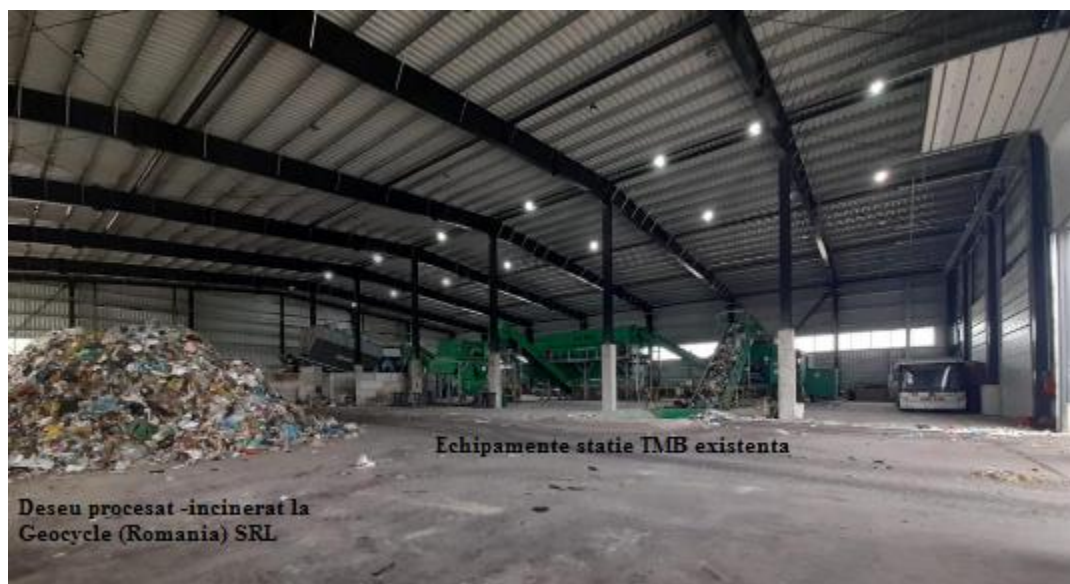
Foto 1: Instalatia de tratare mecanica – vedere interioara
