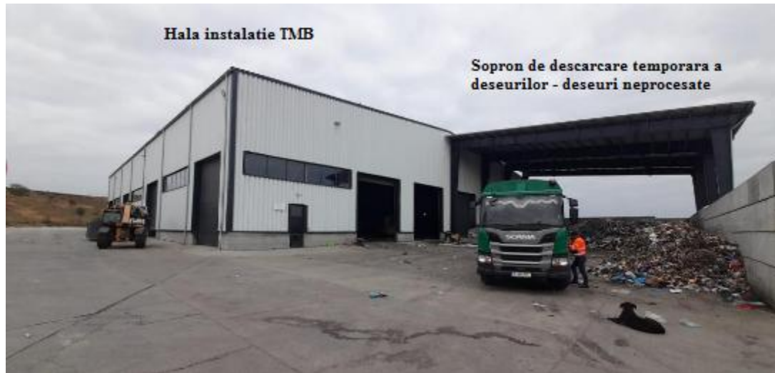
Foto 2: Instalatia de tratare mecanica – vedere exterioara
