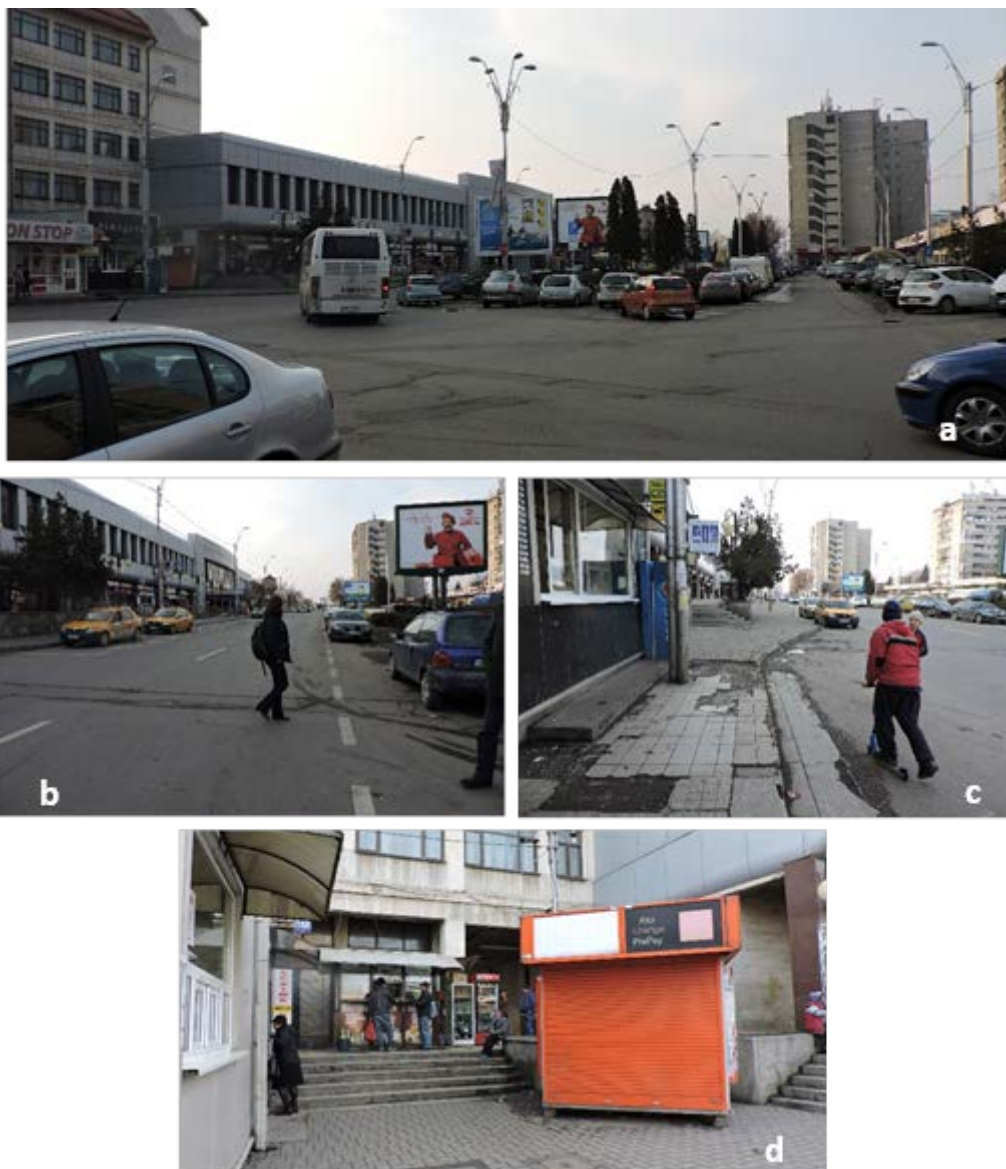
Figura 101: Zona gării: a. Piața Gării – areal de circulație și staționare, cu o slabă calitate estetică; b. proasta amplasare a trecerilor pentru pietoni generează traversări neregulate și pericol de accidente; c. infrastructură pentru pietoni și stații de transport cu o foarte slabă calitate funcțională și estetică; d. inaccesibilitatea spațiului public pentru persoane cu mobilitate redusă
