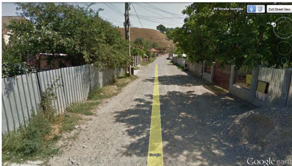
Figura 18: Str. Siretului – arteră majoră în cartierul Șerbănești, conform reglementărilor PUG – fără infrastructură pentru pietoni și cu un prospect subdimensionat pentru o viitoare deservire cu transport public
