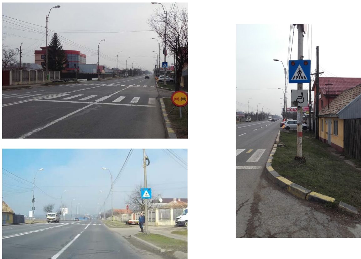
Figura 53: Trecere de pietoni amenajate necorespunzător. Calea Romanului
