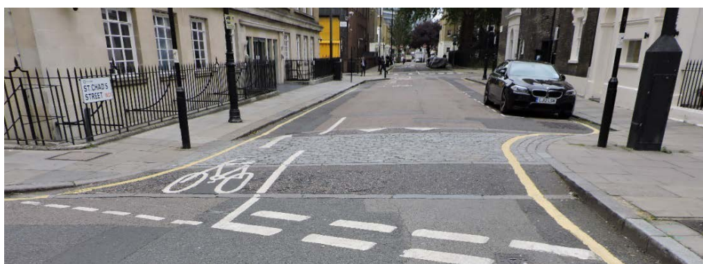
Figura 148: Exemple de amenajări ale trecerilor de pietoni accesibile pentru persoanele cu dizabilități
