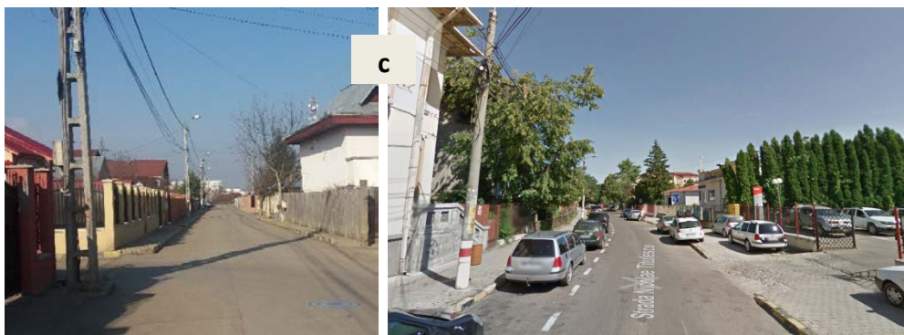
Figura 77: Disfuncții ale infrastructurii pentru pietoni: a. trotuare înguste și/sau ocupate cu mașini parcate în cartierul Republicii II; b. trotuare în stare fizică proastă; c. trotuare obstrucționate de stâlpi sau cu mașini parcate în zone de interes
