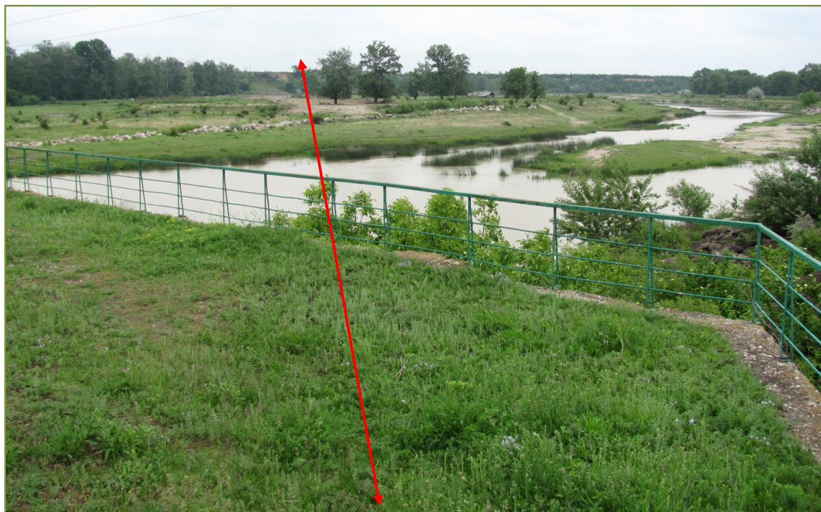
Obiectul 2 – Pod cu lungimea de 465 m peste Canalul Lileci și râul Bistrița, aval de barajul Lacului Lileci
