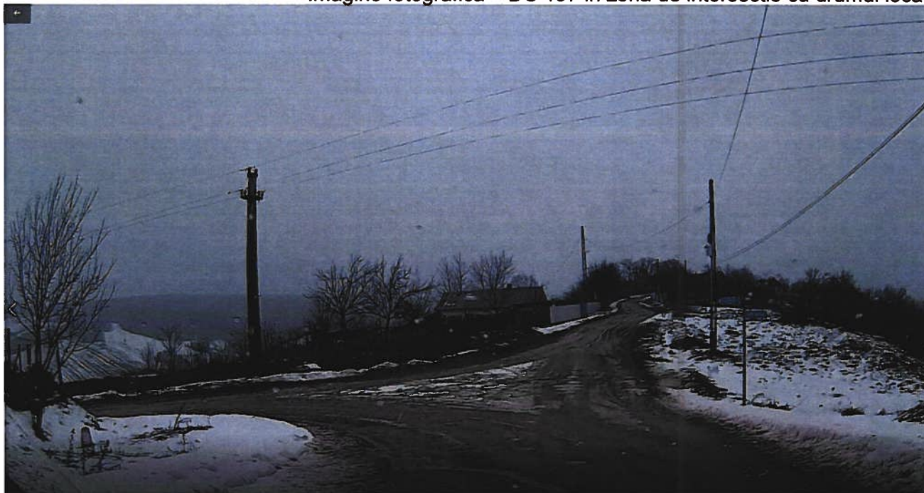
Imagine fotografica – DC 197 in zona de intersectie cu drumul local
