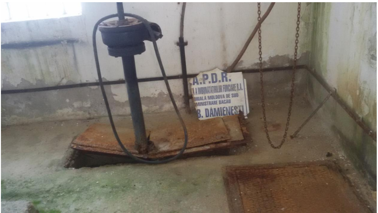
Roată de manevră cu tijă pentru acționare vana plină DN1000 mm
