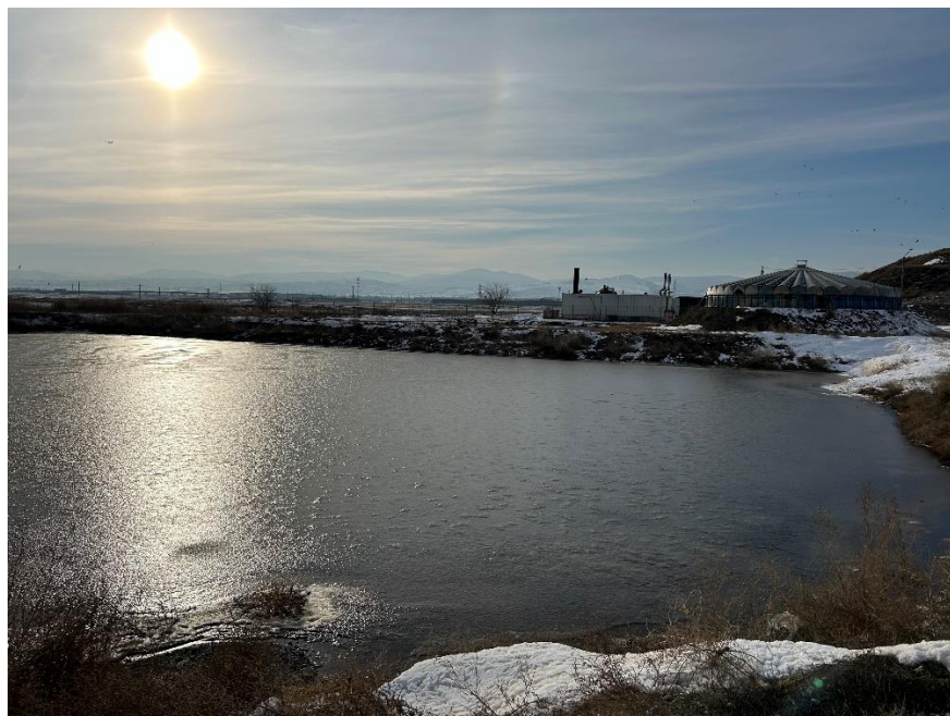
Foto. 15 Bazin de colectare permeat și ape pluviale
