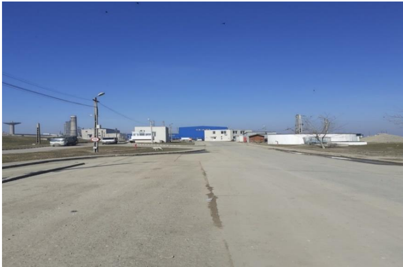
Foto. 12 Drumuri de acces interioare
