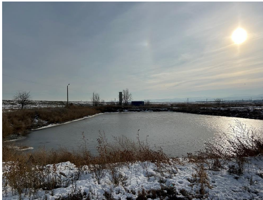
Foto. 14 Bazin de colectare permeat și ape pluviale
