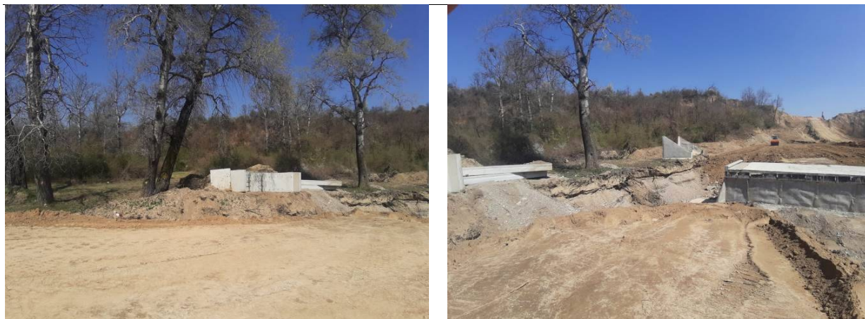
Aspecte ale vegetației existente in amplasamentul suprafeței care urmează a fi defrișate
