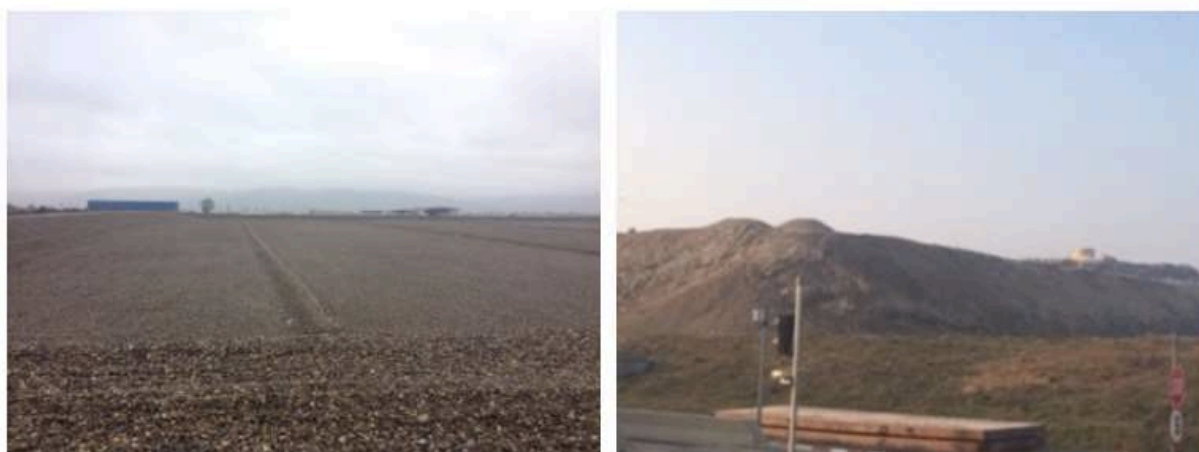
Figura 4-19: Celula 2 a depozitului conform de la Bacău
