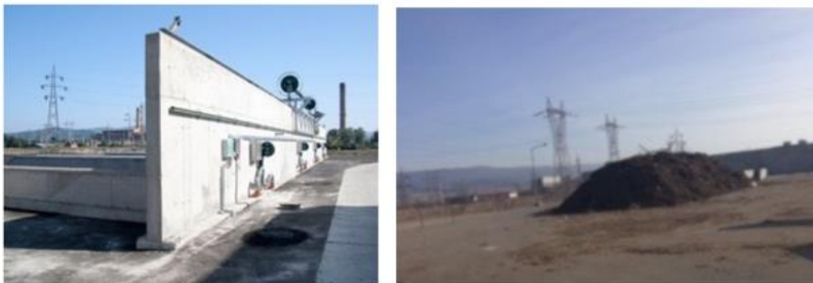
Figura 4-15: Stația de compostare Onești
