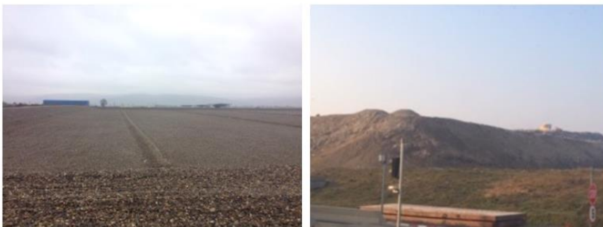
Figura 4-17: Celula 2 a depozitului conform de la Bacău
