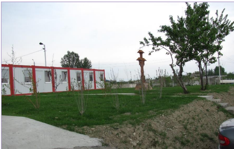
Figura nr. 14. Sediul organizării de șantier
