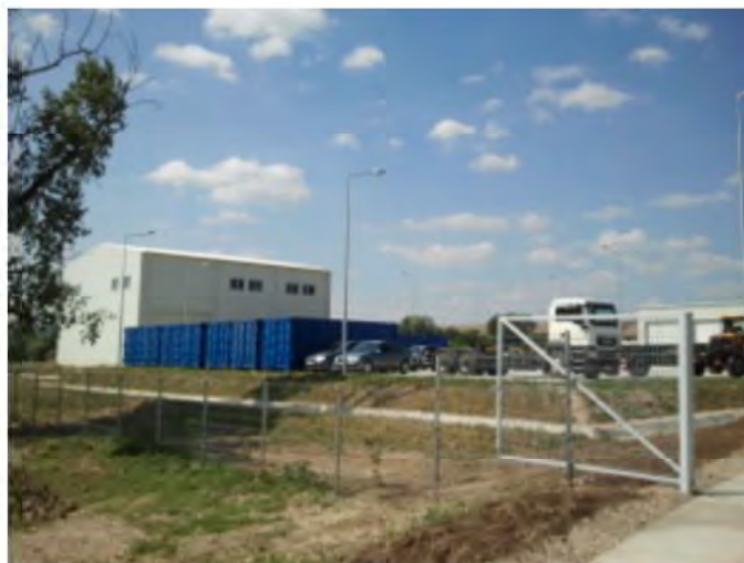
Foto : stație de transfer Berești Tazlău
