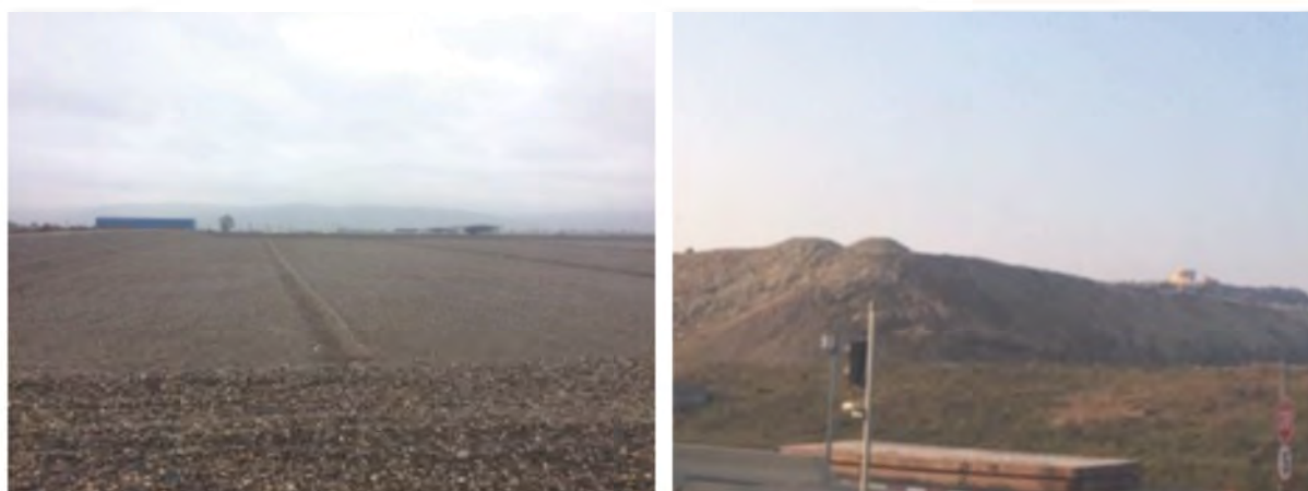
Figura 4-17: Celula 2 a depozitului conform de la Bacău
