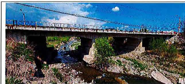
Foto. 3 – Vedere dinspre aval
