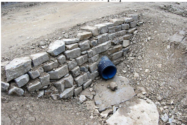
Fig. 10. Radier amonte podeț tubular
