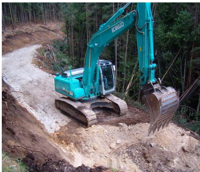
Fig. 6. Excavator în funcționare normală
