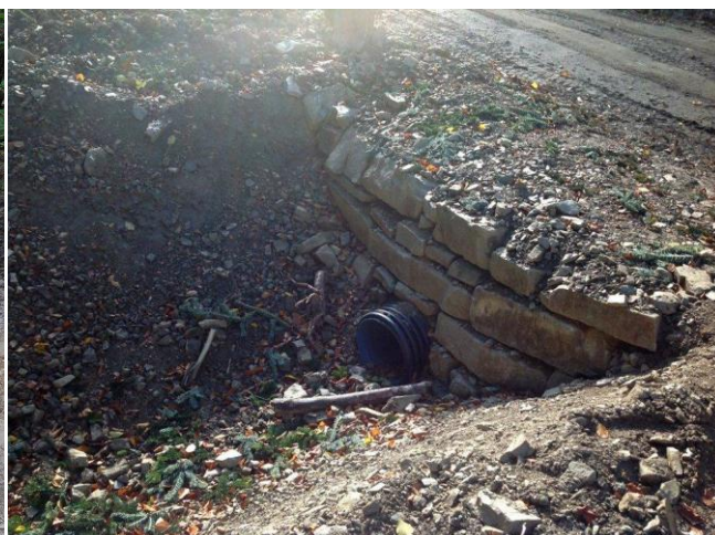
Fig. 9. Racordare aval podeț tubular descărcare șanț
