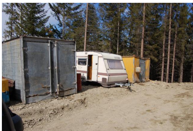
Fig. 15 Organizare de șantier SC Argedemolari srl, DAF Celaru - jud. Neamț
