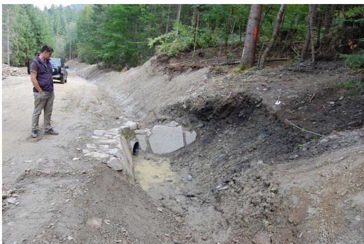
Fig. 8. Racordare amonte podeț tubular descărcare șanț
