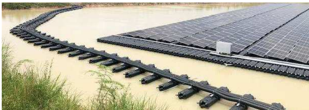
Fig.2 Vedere generală a zonei parcului fotovoltaic plutitor
