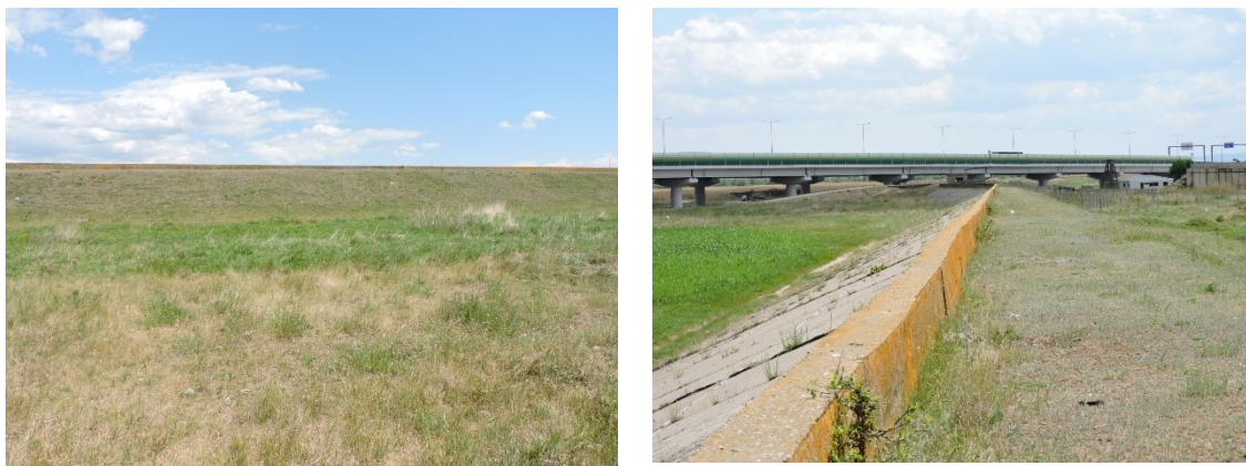
Figura 64 Digul de protecție existent în vecinătatea ITDCS
