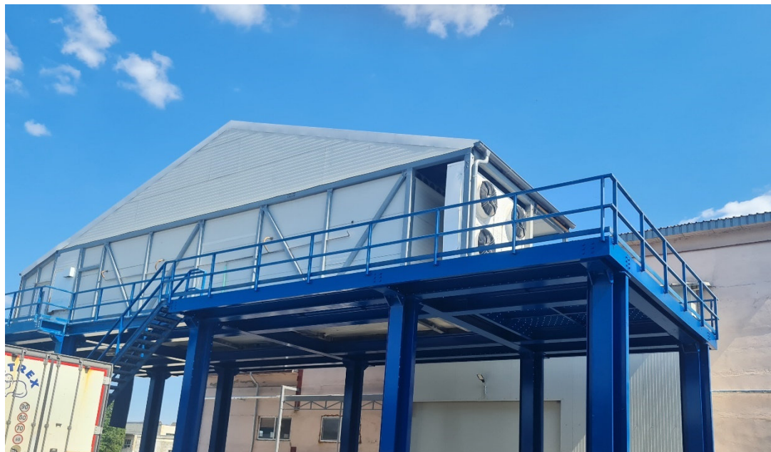
Figura nr. 9. Container frigorific cu capacitatea de 30 tone pentru stocarea viscerelor
