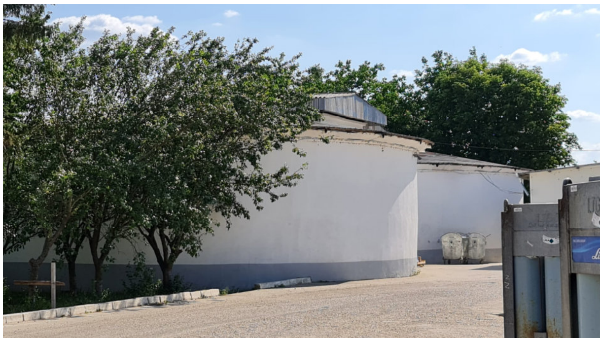
Figura nr. 13. Rezervoare de înmagazinare a apei
