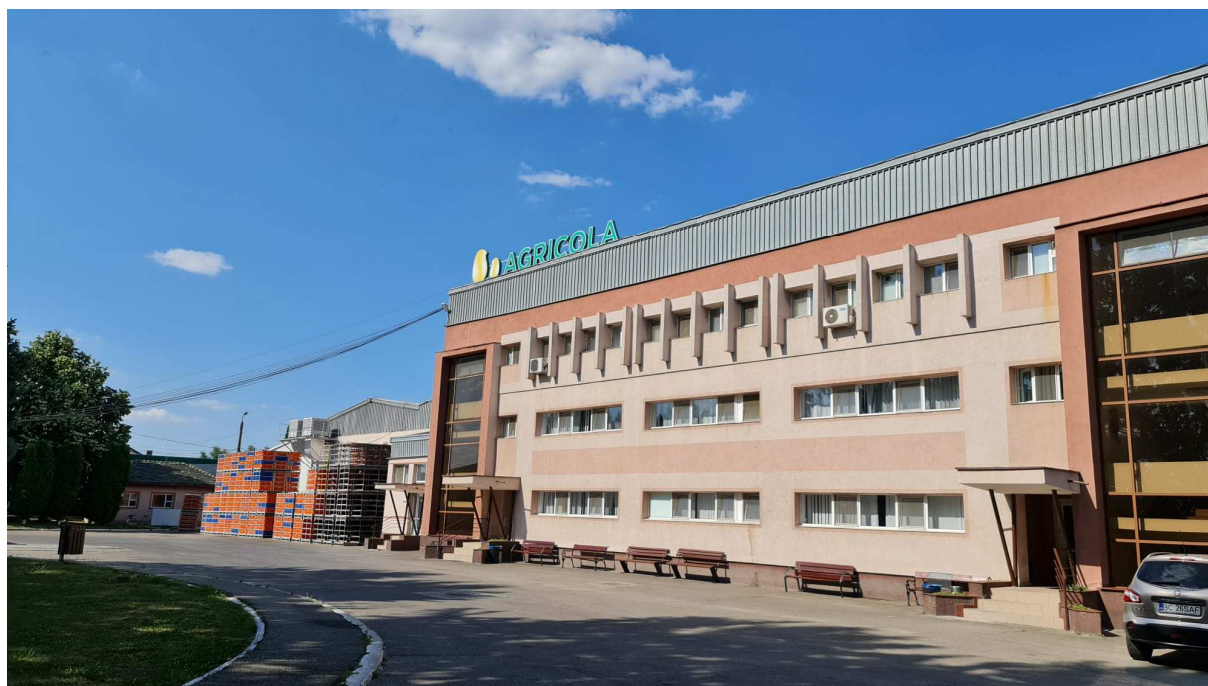
Figura nr. 2. Clădire abator păsări
