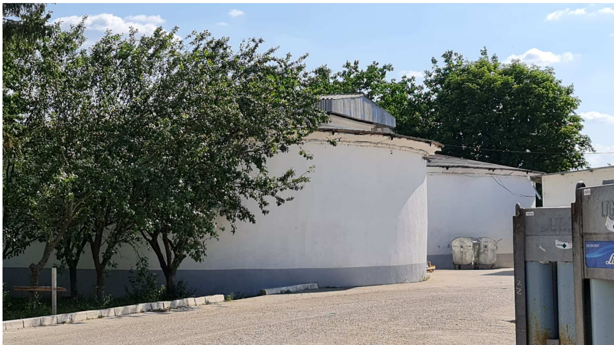
Figura nr. 13. Rezervoare de înmagazinare a apei
