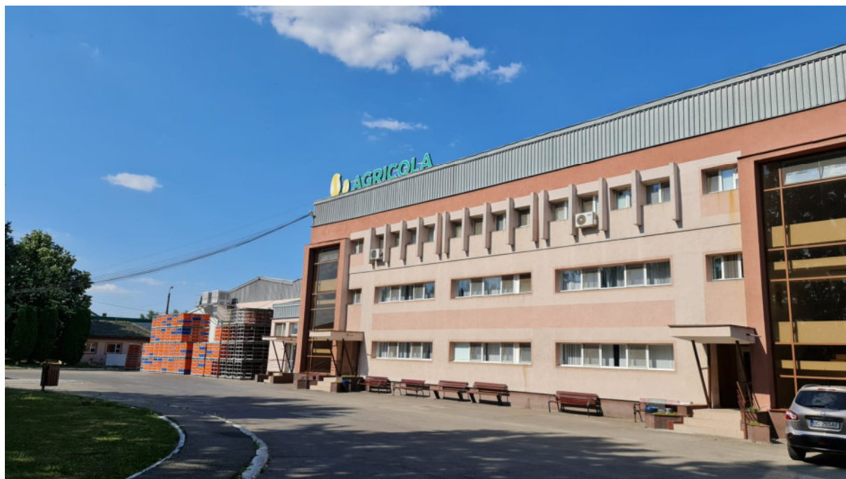
Clădire abator păsări
