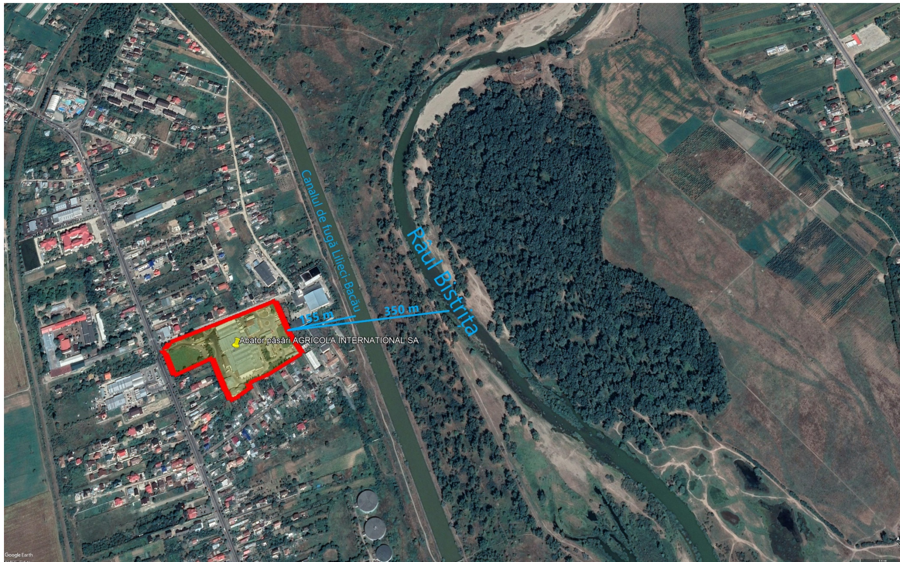
Figura nr. 20. Localizarea AGRICOLA INTERNATIONAL SA – Abator păsări – în raport cu râul Bistrița și canalul de fugă al râului
