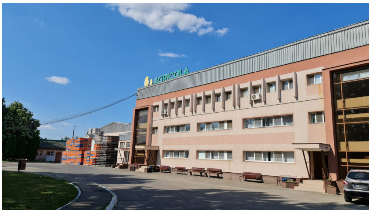
Figura nr. 2. Clădire abator păsări
