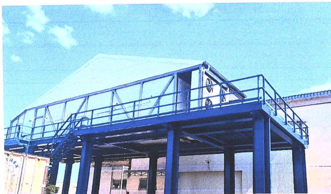
Figura nr. 11. Container frigorific cu capacitatea de 30 tone pentru stocarea viscerelor
