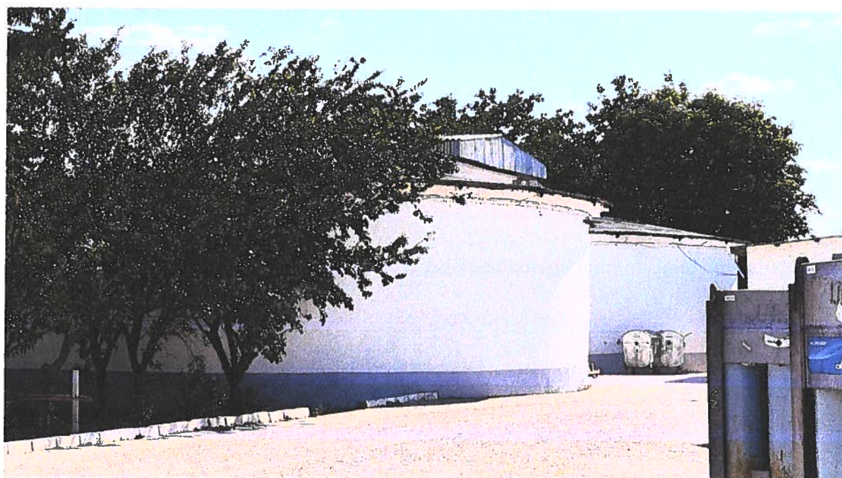
Figura nr. 15. Rezervoare de înmagazinare a apei
