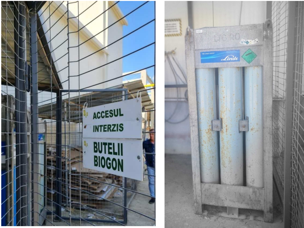
Figura nr. 16. Spațiul de depozitare a buteliilor de BIOGON
