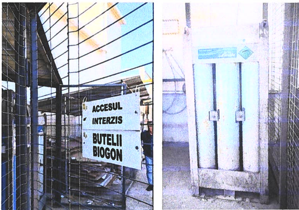
Figura nr. 21. Spațiul de depozitare a buteliilor de BIOGON
