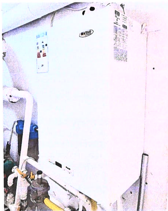
Figura nr. 11. Centrala termică murală MOTAN cu P=24 kW (pentru asigurarea apei calde la cantină)
