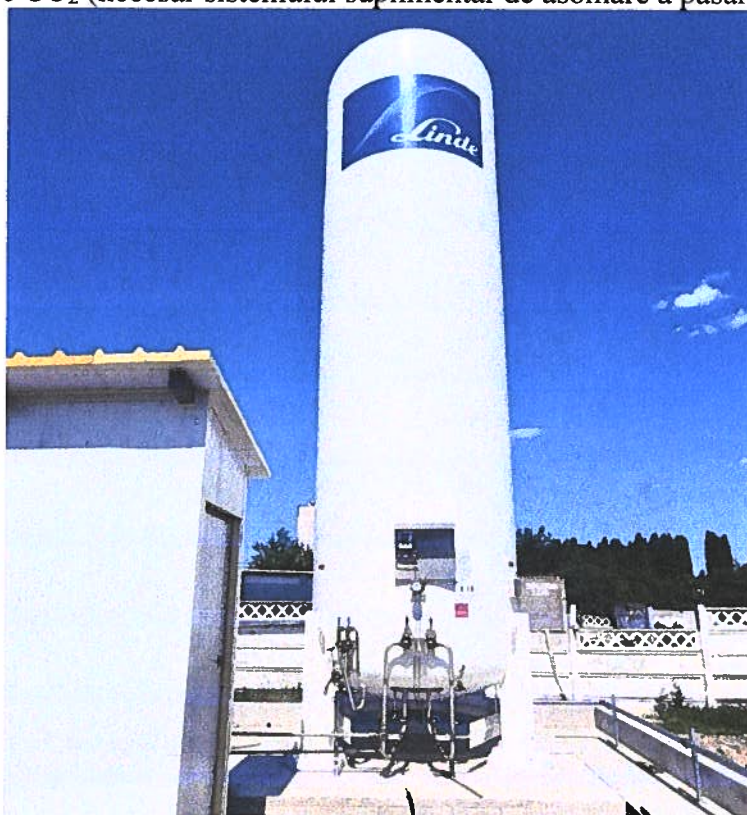
Figura nr. 14. Rezervor de \text{CO}_2
