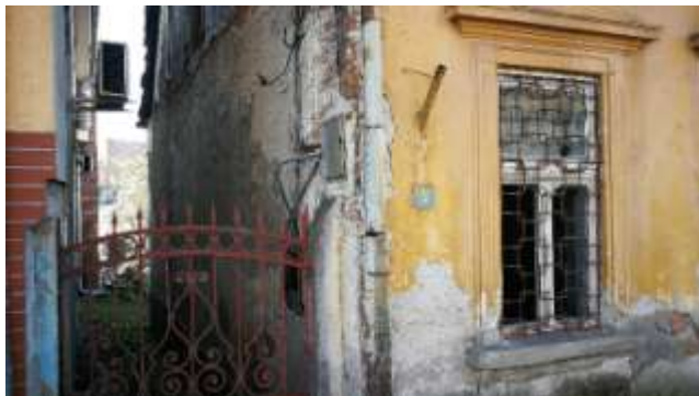
Vedere construcție S+P din str. Bobâlna
