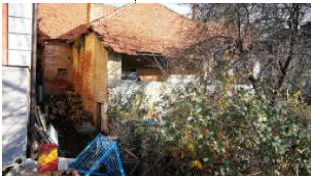
Vedere construcție S+P dinspre curtea Primăriei
