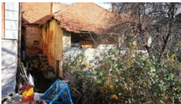
Vedere construcție S+P dinspre curtea Primăriei
