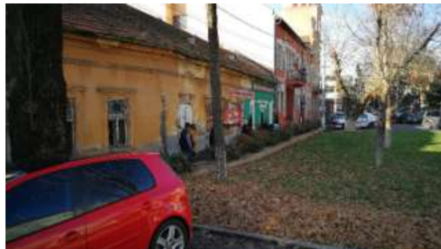
Vedere construcție S+P din str. Bobâlna
